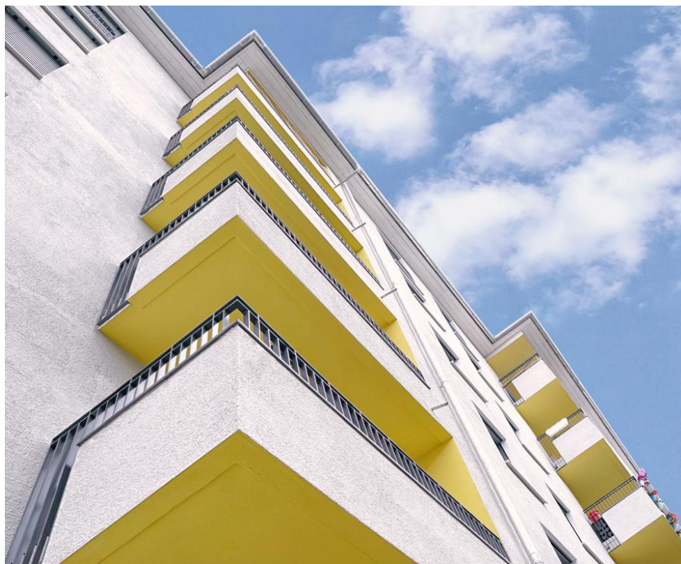
Abb. 3 und 4: Für eine Wohnungsbaugesellschaft sanierten grabow klausen Architekten aus München ein ganzes Ensemble aus 1950er Jahre Wohnzeilen mit einem Wärmedämmverbundsystem (WDVS) aus Mineralwolle. © Foto: grabow klausen Architekten
