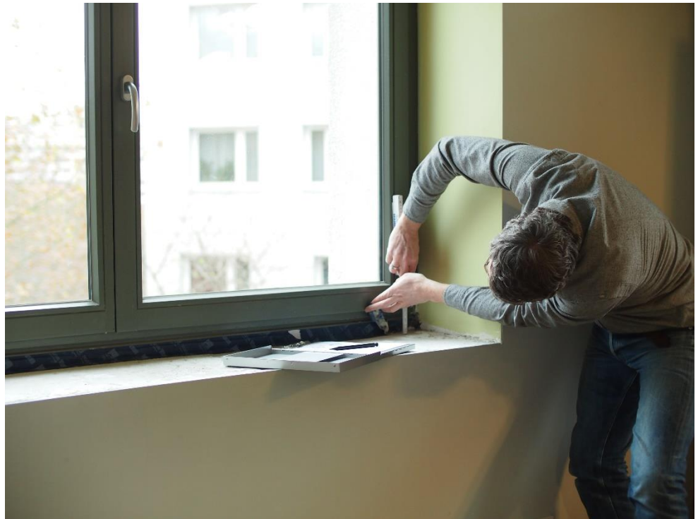
Abb. 3: Bei der Fenstererneuerung muss auch der Bauteilanschluss wärmebrückenreduziert und dauerhaft luftdicht ausgeführt werden.
