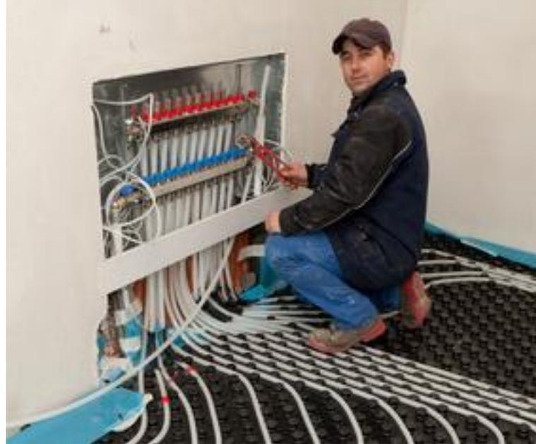
Abb. 5: Handwerker verlegt eine neue Fußbodenheizung,
